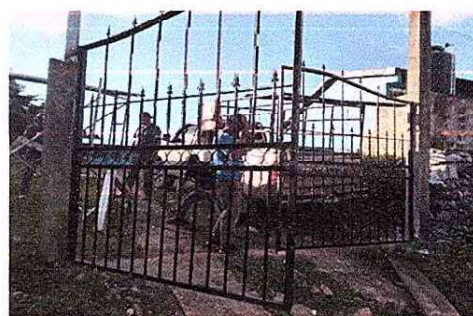
Foto 6: Sustitución de Porton.
