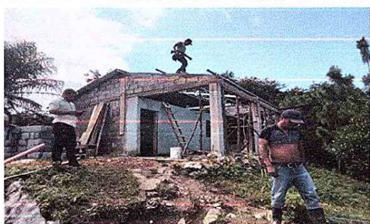
Foto1: Sustitución de costaneras de aulas en mal estado.
