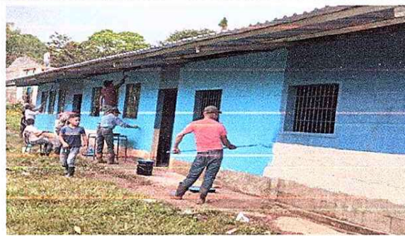
Foto 4: Sustitución de pintura exterior del aula.
