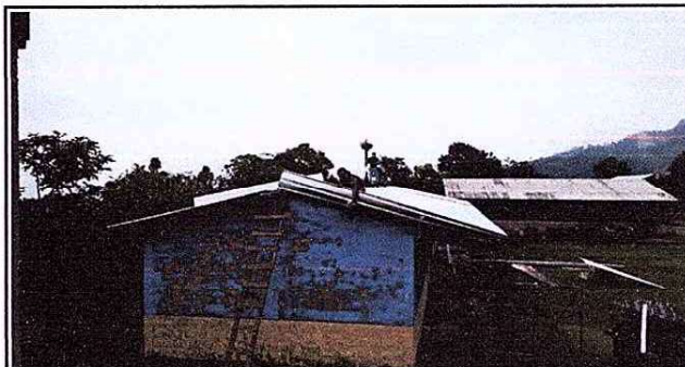
Foto 2: Sustitución de laminas de aulas en mal estado.
